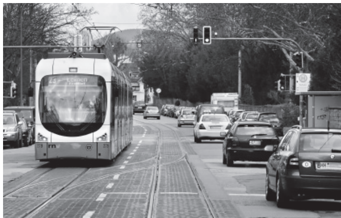
Rohrbacher Straße: Sanierung beginnt im Mai Foto: Rothe
