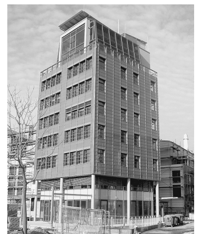
Der Kraus-Turm auf dem Gelände der Glockengießerei Foto: Kraus-Immobilien
